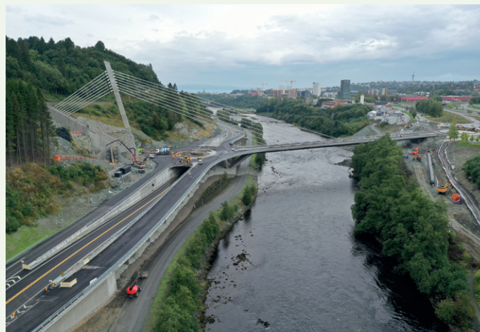
Prosjektet omfatter ikke bare brua. En ny sykkelveg med fortau og også diverse påkjøringsramper, mindre bruer og tilførselsveg til E6 er deler av jobben. Foto: Statens vegvesen/Vegard Thorvaldsen
