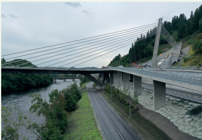
Åtter måneder før planen kunne Nydalsbrua i Trondheim åpnes. Den er blitt et landemerke i byen. Foto: John Inge Vikan.
