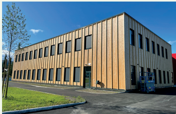
Nybygget består av parkeringskjeller, lager, tekniske rom og garderober i underetasjen.
