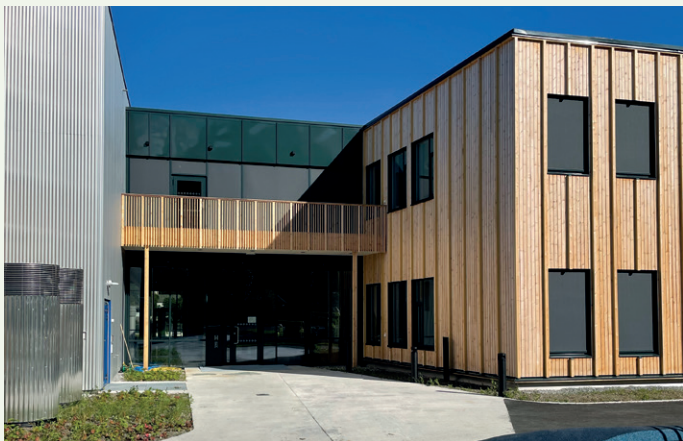
Byggestart var i april 2022, og bygget sto ferdig i juni 2023.
