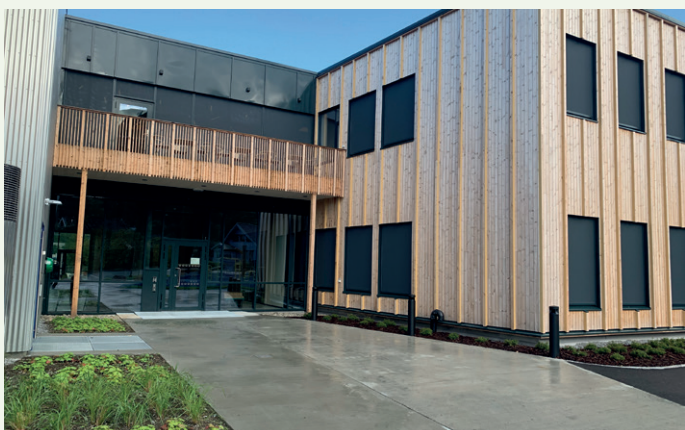
Inngang til aktivitetshuset og rådhuset fra baksiden.
