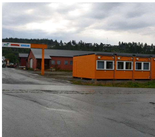
Anleggskontor og mannskapsbrakker vil ligge på Sande-tomta i sentrum av Berkåk. Riggen vil bli mye mer omfattende etter hvert, før det hele skal være på plass 1. september.
